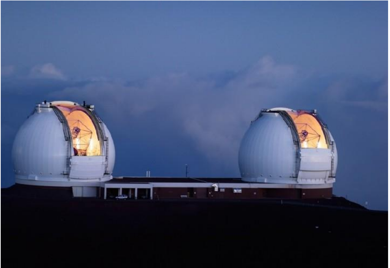
Американские телескопы «Кек I» и «Кек II», Гавайи, гора Мауна Кеа, 1993 и 1996 гг Диаметр зеркала 10 м
